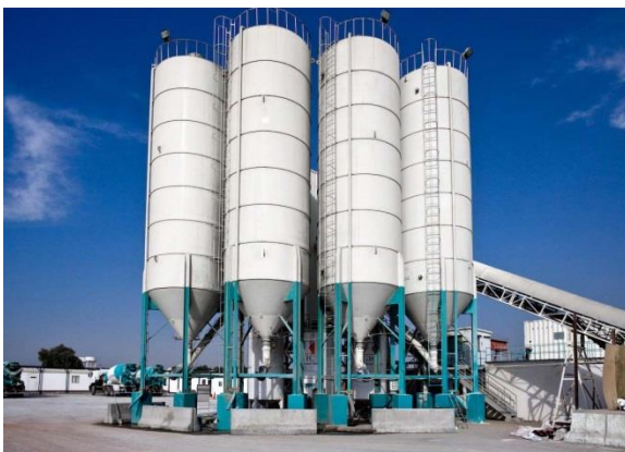
Figura 2 Esempi di strutture, silos e serbatoi sferici, che possono essere modellati come gusci assialsimmetrici
